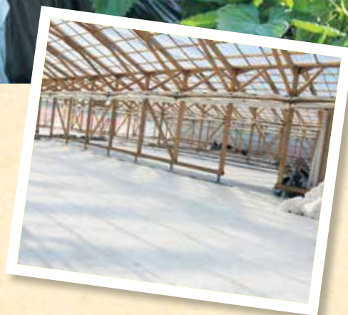
現在増設中の木骨ハウスの内部
